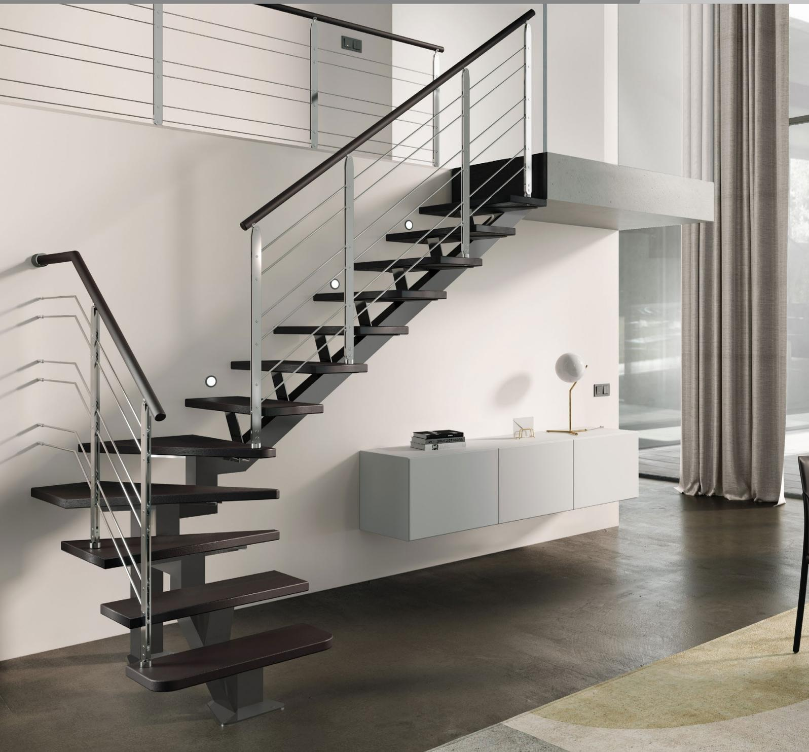
**STRUCTURE** : composée d'une poutre en acier de dimension 100 x 100
