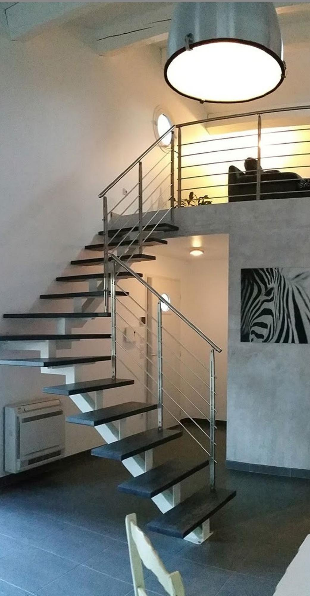
**STRUCTURE** : porteuse centrale par une poutre en acier
